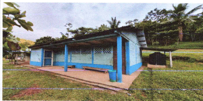
Foto 3: Sustitución de puerta de madera por puerta de metal.
