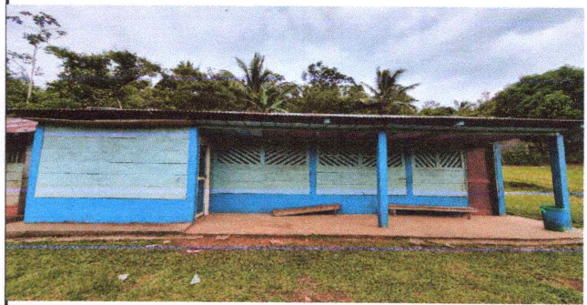
Foto 2: Sustitución de madera por block entremedio de las columnas de concreto que ya existe en el edificio.
